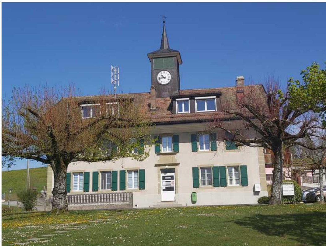
L'ancien collège de Servion qui accueille l'administration générale (greffe - bourse - contrôle des habitants, salle et bureaux de la Municipalité).
