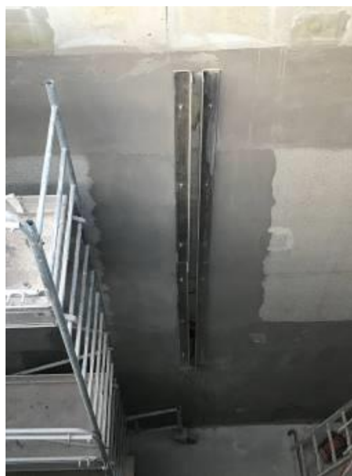
Application des couches de protection.
