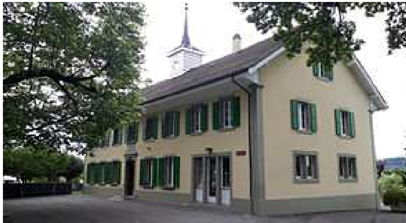
Ancien Collège de Les Cullayes avec au rez-chaussée « La Place du Village »
