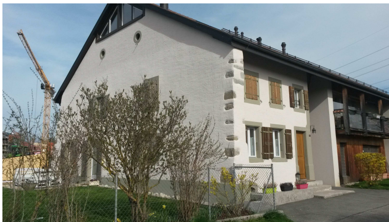
Bâtiment « La Retraite » à Servion
