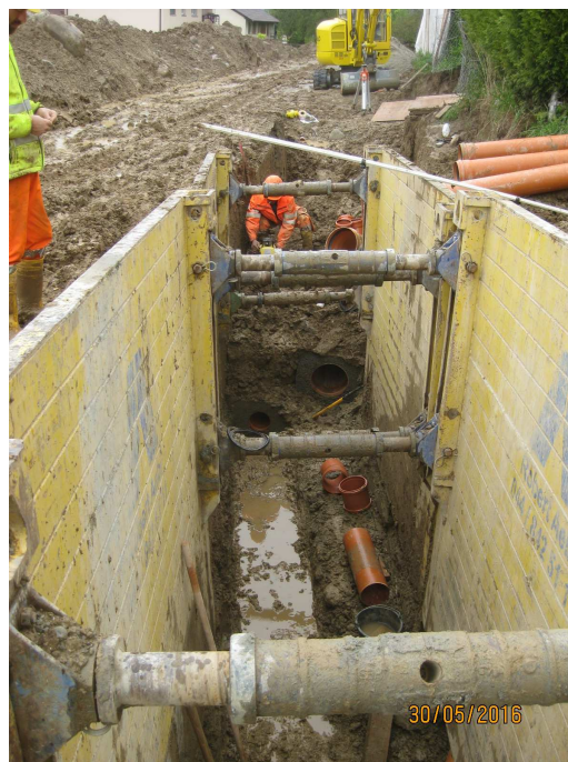
Réfection des collecteurs dans le quartier du Praz du Perey à Servion des travaux de grande envergure.
