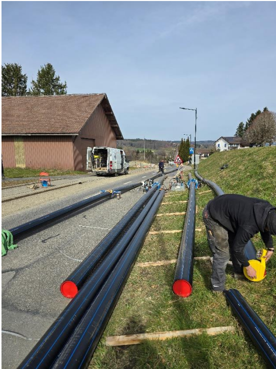
Préparation de la conduite à Les Cullayes
