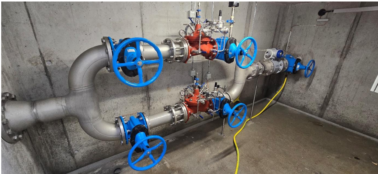
Chambre coupe pression de la liaison Montpreveyres et à Les Cullayes
