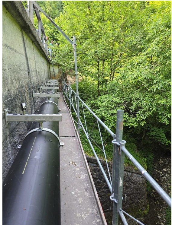
Passage sur le parapet du pont de la Bressonne
