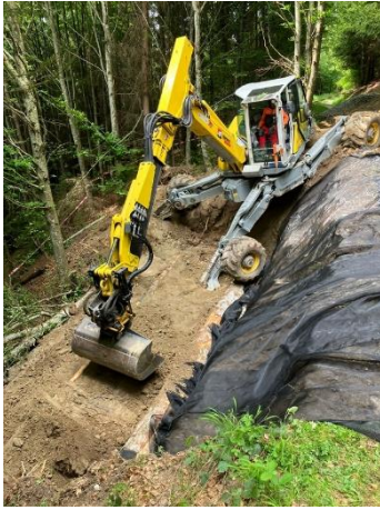
photos des travaux d'excavation et du renforcement du chemin
