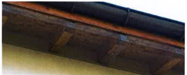
Adéquat – Grillage protégeant la façade aux endroits sensibles.
